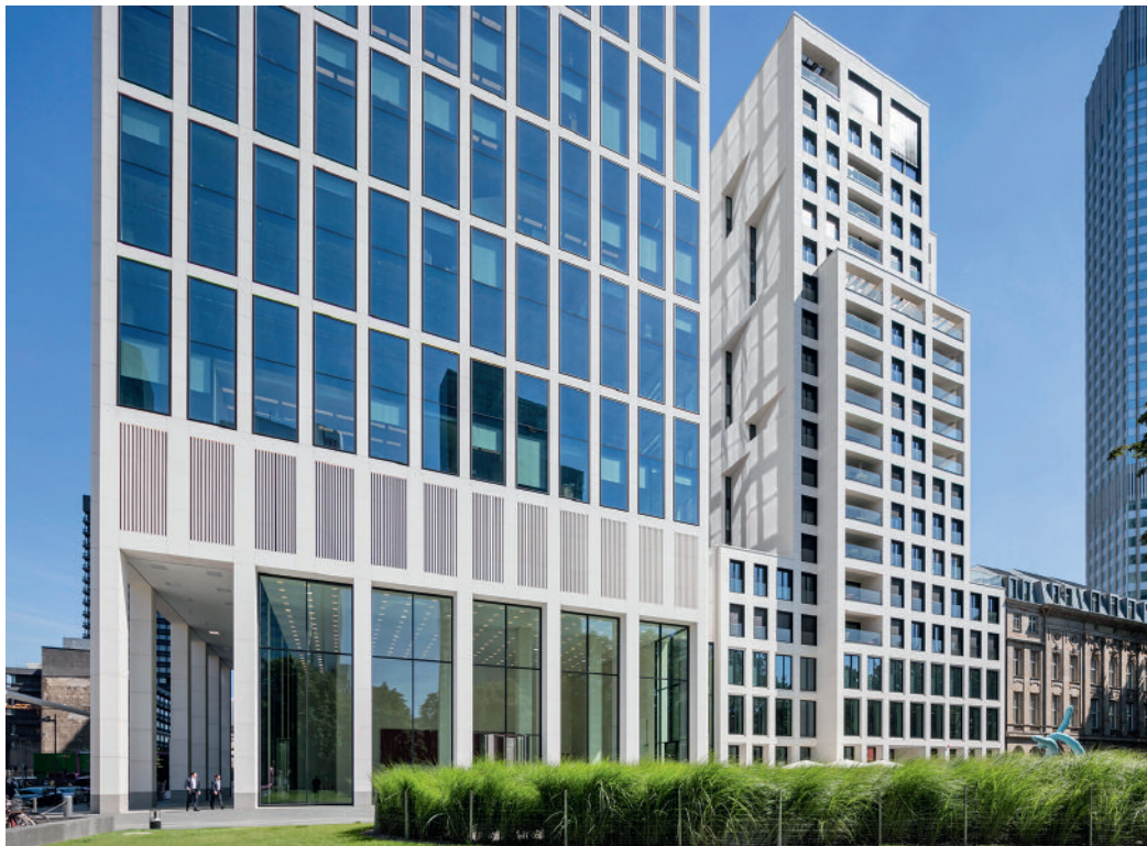
Der Taunusturm in Frankfurt gilt als eines der Vorzeigeobjekte, wenn es um die Themen ökologisches Bauen geht. (Fotos: Tishman Speyer)
